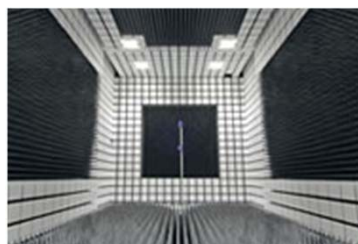
大型電波暗室
